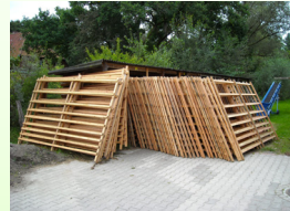
Bau von Wildschutzzäunen in der WfbM SOS Hof Bockum
